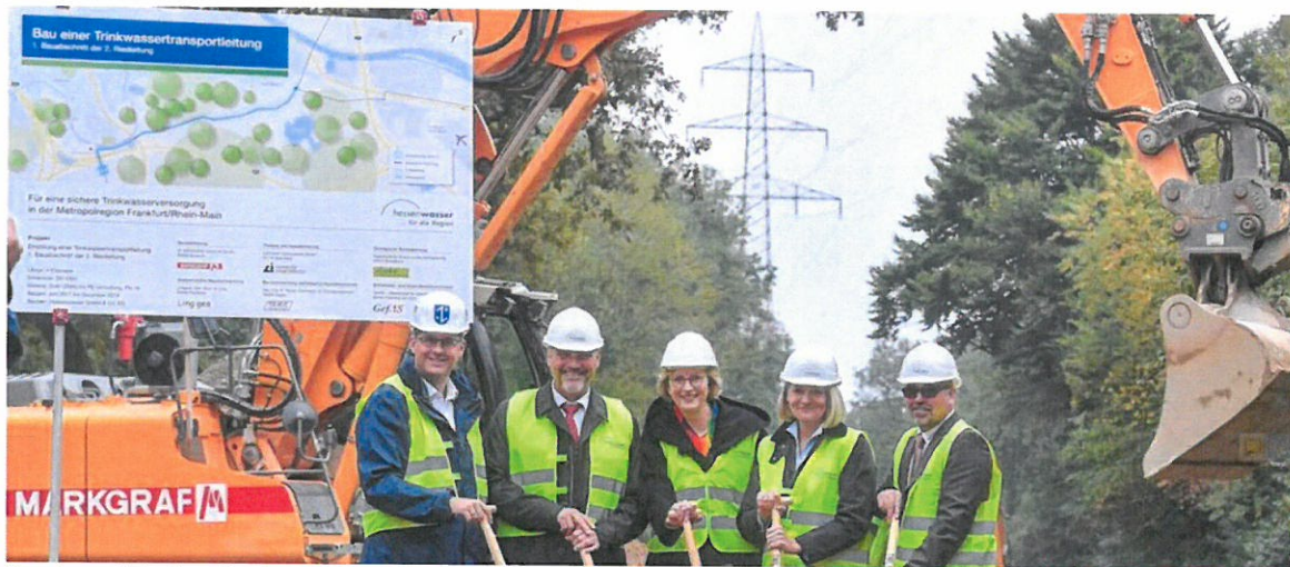
Spatenstich für die neue Wasserpipeline
